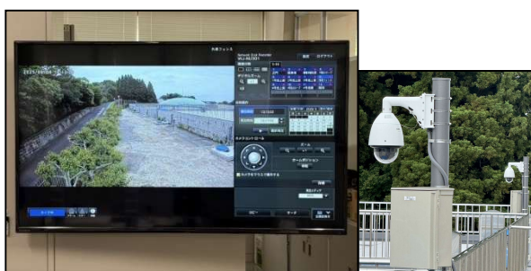
監視カメラ設備設置(東金配水場)
