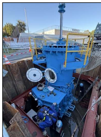
場内連絡管耐震化（東金配水場） 不断水バタフライ弁 口径700mm 設置
