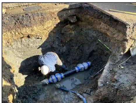
漏水修理工事
