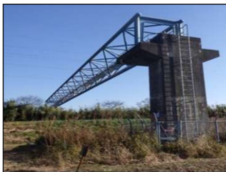
更新を予定している南白亀川水管橋 鋼管 口径 300mm 配管長 54m（縦 1 号幹線）
