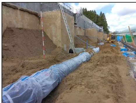
場内連絡管耐震化（東金配水場） ダクタイル鋳鉄管（NS形） 口径700mm 布設
