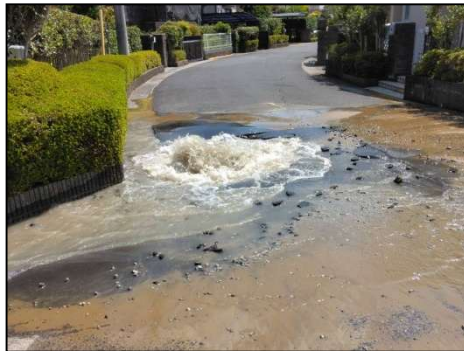
布設後約 40 年が経過した管の漏水 硬質塩化ビニル管 口径 75mm
