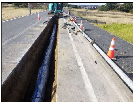
重要給水施設配水管耐震化 ダクタイル鋳鉄管（GX 形） 口径 300mm 指定避難所へ給水している配水管
