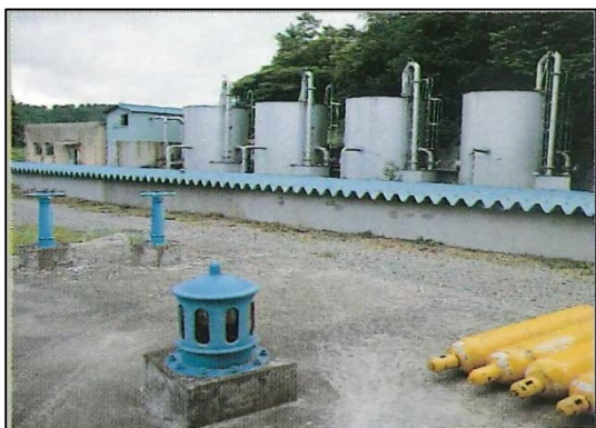
昭和29年完成・平成9年廃止 （施設能力 4,200m 3 /日）
