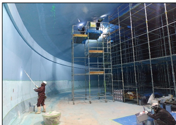
東金配水場 4号配水池内面補修塗装工事 (令和4年度)
