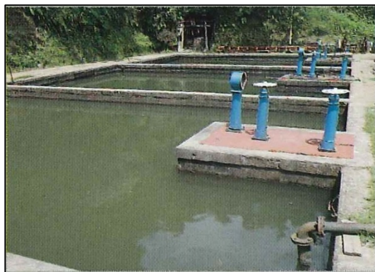
昭和5年完成・平成3年廃止 （施設能力 1,300m 3 /日）
