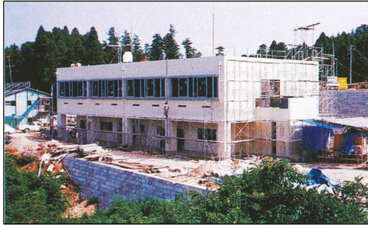
建設中の東金配水場
