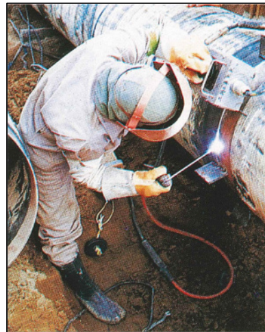
配水管整備事業
