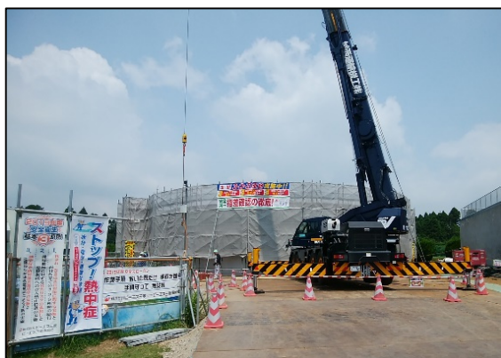
松尾配水場 3号配水池築造工事 (令和元年度)
