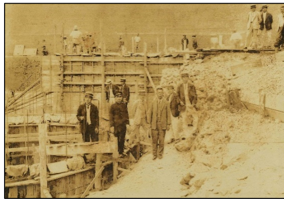
谷浄水場建設工事
