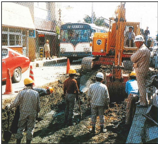
配水管布設替事業
