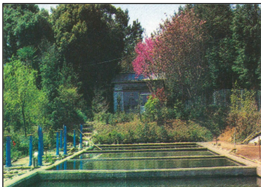
昭和33年完成・昭和60年廃止 （施設能力 800m 3 /日）
